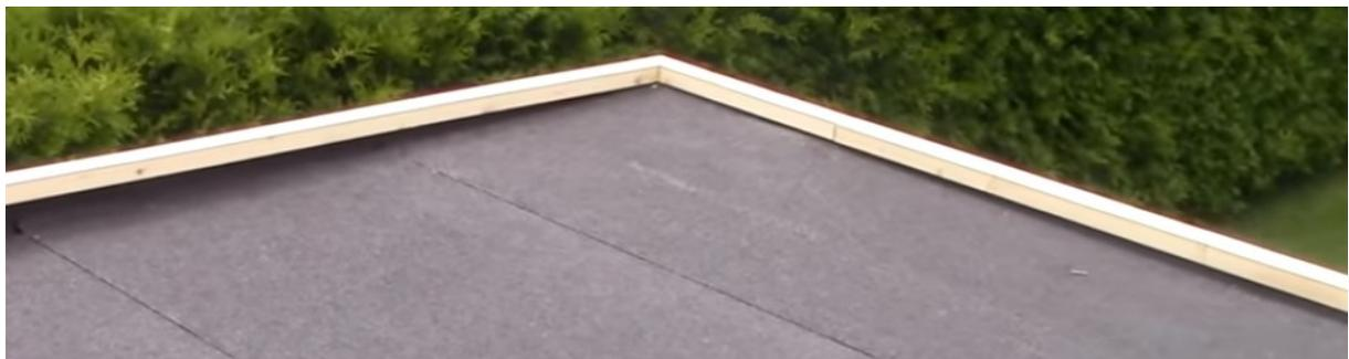
Para casetas con tejado a un agua sin parapeto, utilizamos bordes laterales (en forma de L - dos tablas unidas con tornillos), tablas de alero y listones de refuerzo para las tablas de alero. Primero monte los listones de refuerzo debajo de las tablas de techo y fijelos con
