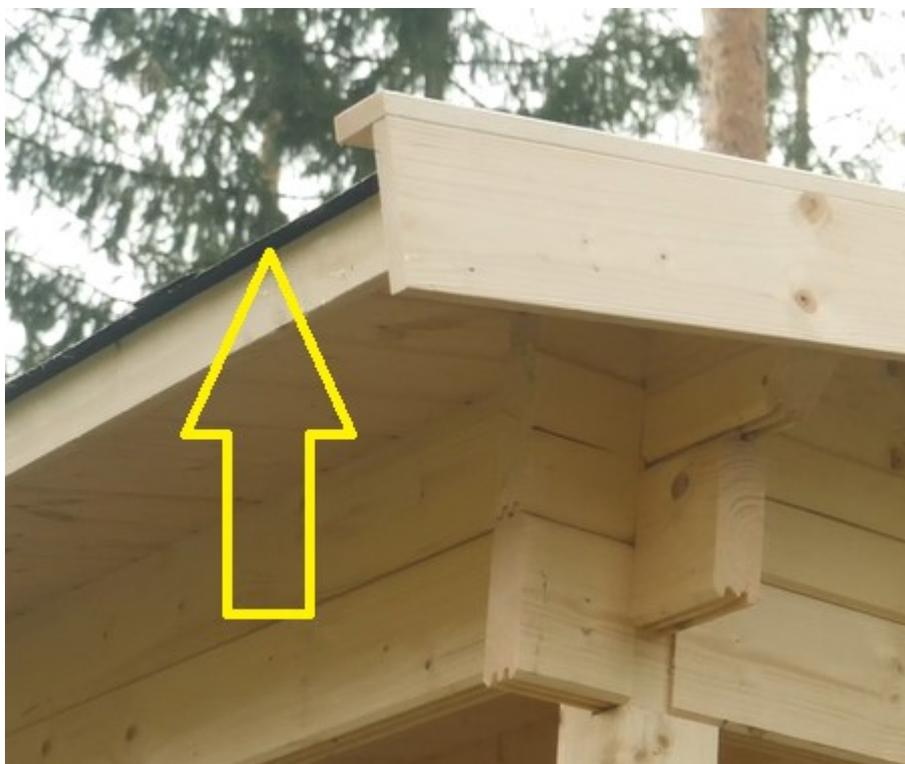
Después, fije con tornillos las tablas del hastial y los bordes laterales.
