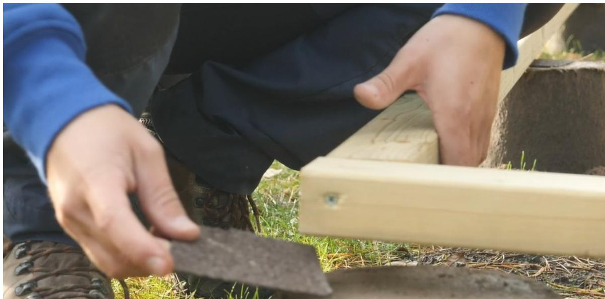
Como alternativa, puede cubrir toda la base con tela asfáltica. En este caso, recomendamos taladrar en las vigas de base agujeros de 10 mm de diámetro, con una distancia aproximada de 1 metro entre ellos. Así habrá suficiente ventilación para eliminar la humedad.
