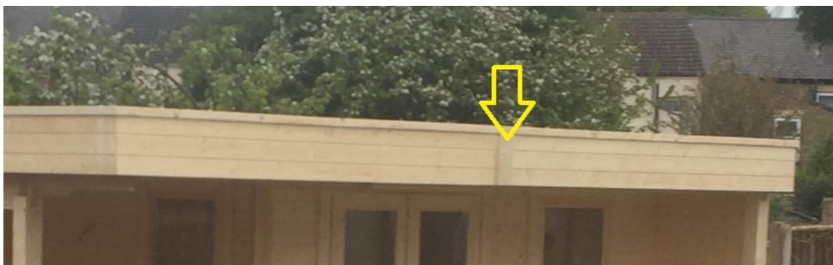
Los parapetos tienen que atornillarse en los extremos de las vigas en las paredes laterales, y en los tablonces laterales superiores en la fachada y en la pared trasera de la caseta. Los parapetos delantero y trasero hay que fijarlos además a las paredes mediante soportes de parapeto. Utilice tornillos.
