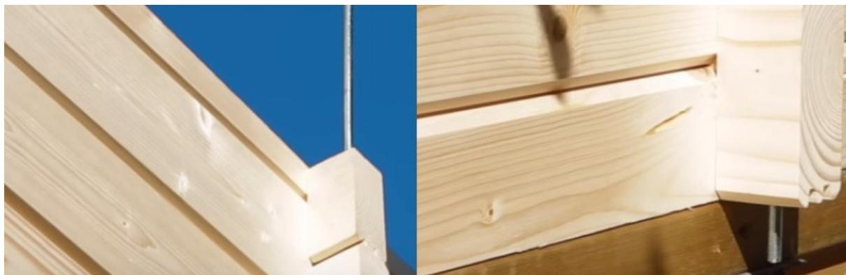
Los listones anti-tormenta de madera para casetas con el grosor de pared 28-40 mm se instalan en la última etapa del montaje. Las instrucciones aparecen en esta guía más adelante.
