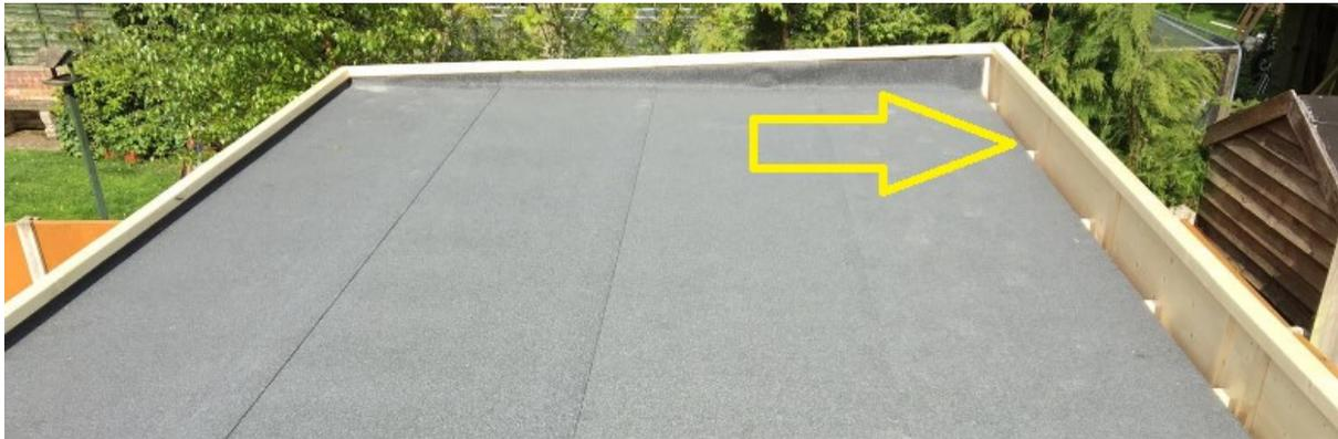
Algunos parapetos tienen listones verticales de unión en el revés. Antes de montar el parapeto de la fachada, tiene que hacer cortes en las tablas de techo para poder meter allí los listones. Permitirá ajustar el parapeto contra el techo en el lado más alto de la caseta. Como alternativa, puede posicionar los listones en la parte delantera del parapeto, sin necesidad de cortar las tablas de techo.
