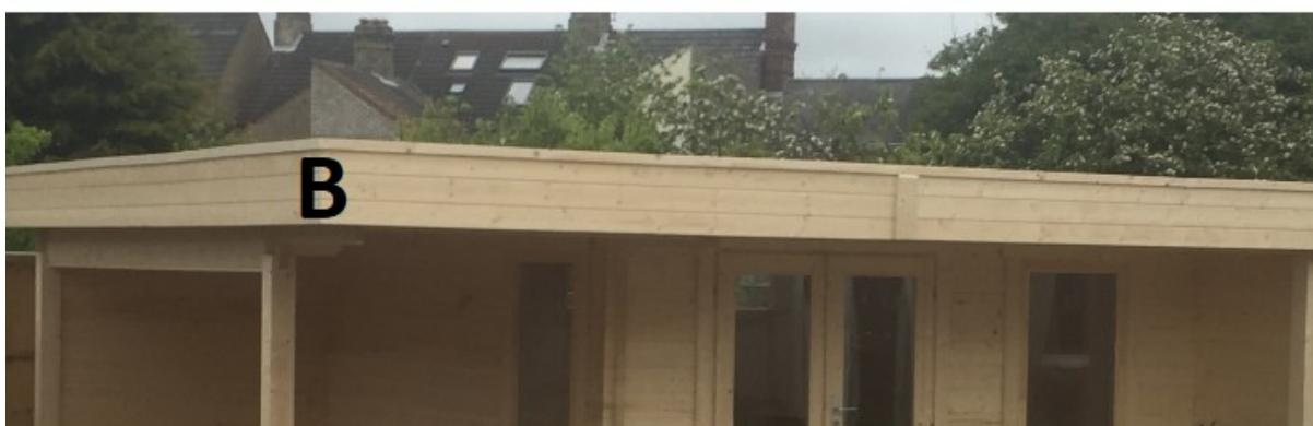
Construya las paredes y monte los tablones superiores de las paredes laterales. Normalmente, los laterales superiores se componen de varias piezas, júntelas utilizando tornillos.
